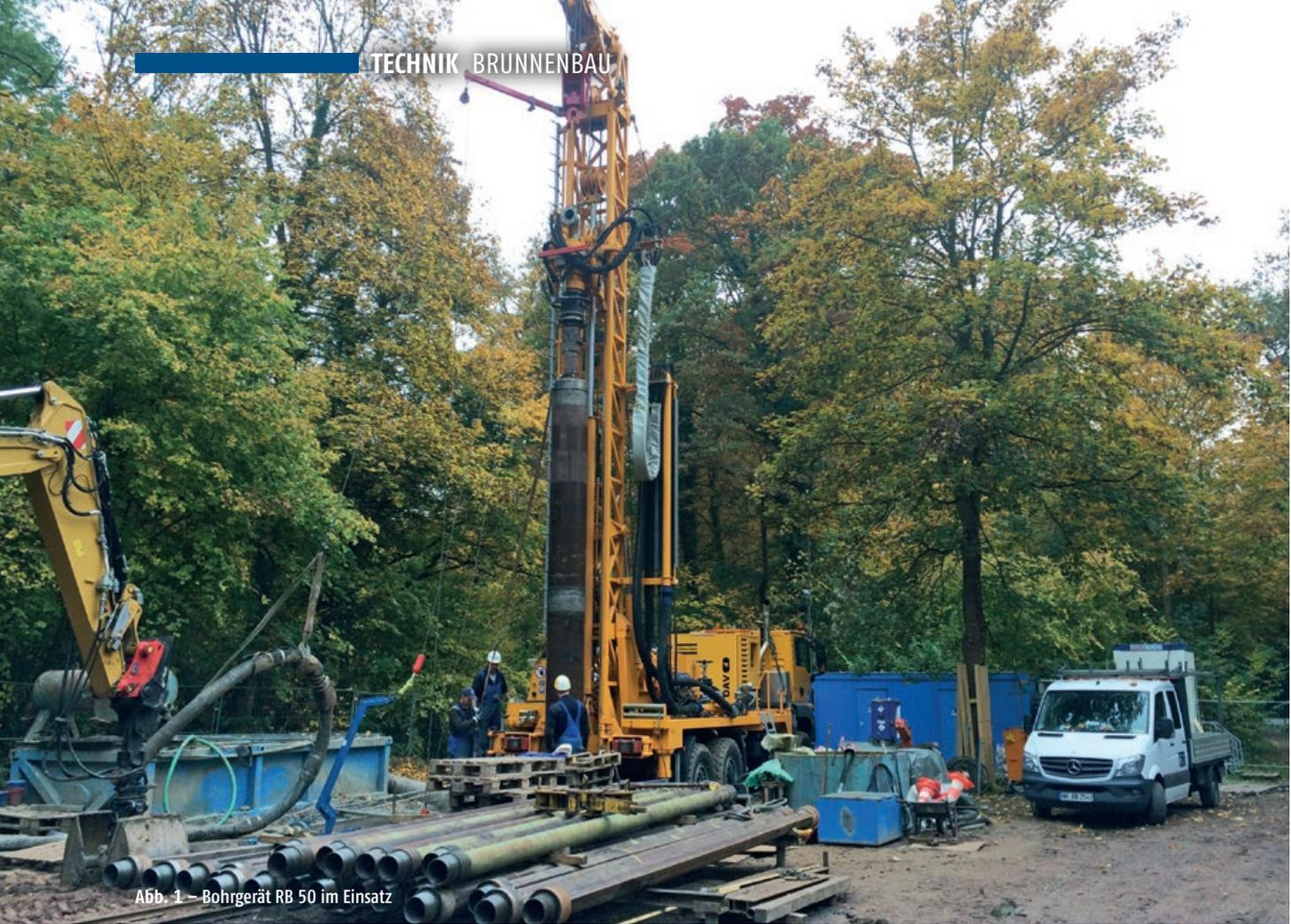
Abb. 1 – Bohrerät RB 50 im Einsatz
