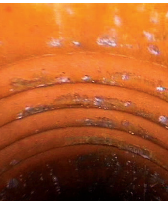
Abb. 3 – Eine für „Gommernrohre“ typische Rohrverbindung mit charakteristischer Wellenform
