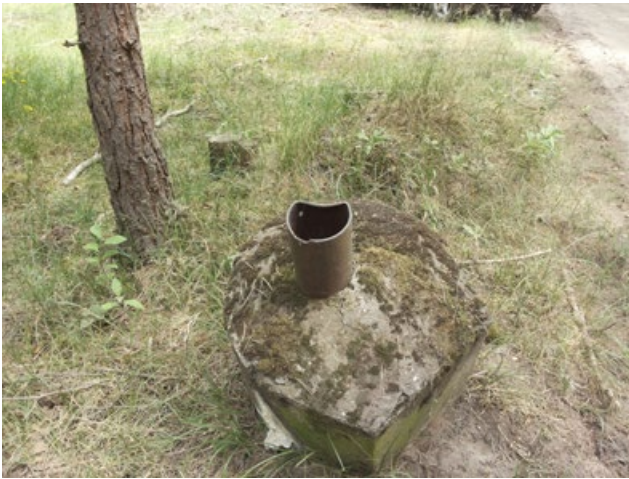
Abb. 2 – Exemplarische Fotodokumentation von zwei beschädigten und nicht mehr funktionstüchtigen Grundwassermessstellen
