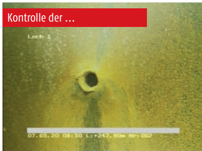
Abb. 6 – Nachweis der Perforationslöcher und des unbeschädigten Kupferrohres
