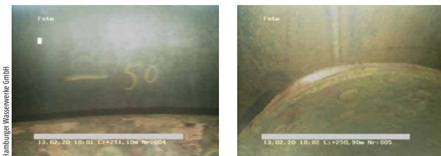
Abb. 5 – Kontrolle des Inliners mittels Kamerabefahrung
