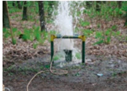
**Abb. 4** Freiblasen der Messstelle mittels Stickstoff
