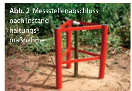
Abb. 2 Messstellenabschluss nach Instandhaltungsmaßnahme
