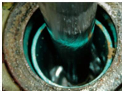
Abb. 8 Sicht in den Altausbau aus DN 125 PVC beim Einstellen des Inliners
