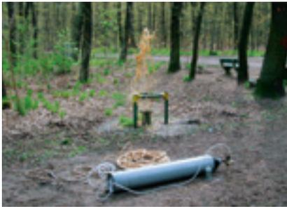
**Abb. 3** Ausblasen und Austrieb von schluffigen Verockerungsprodukten
