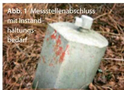
Abb. 1 Messstellenabschluss mit Instandhaltungsbedarf
