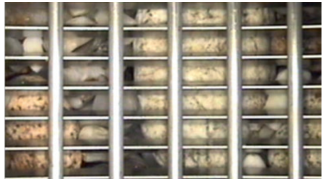
Abb. 13 – Horizontalblick auf Filterrohrausschnitt mit Mischkornfilter aus Filterstützkies und Gebirgsmaterial
